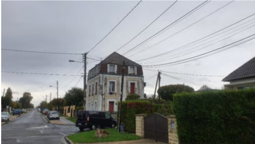
Montfermeil, Avenue de Daniel Perdrigé # trottoir perméable
