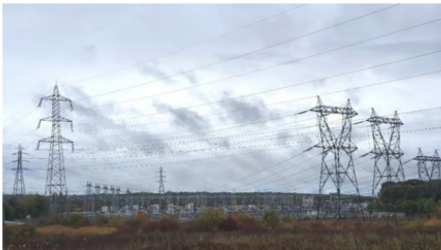
Villevaudé, transformateur RTE, # 2.3 MW pour 2 moi. de personnes en IDF
