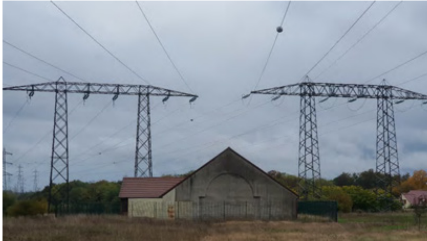
Chelles, Avenue de Liaubon # alimentation électrique
