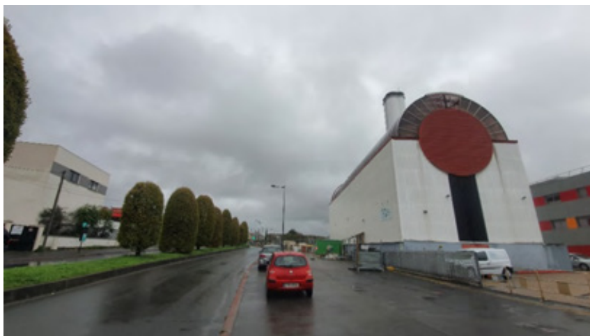
Centrale de chaleur urbain, Avenue de Jean Moulin
