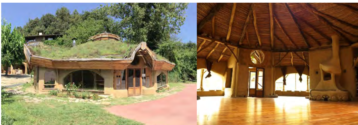
Salle de bioconstruction et coopération et intérieur en bois © Terramans
