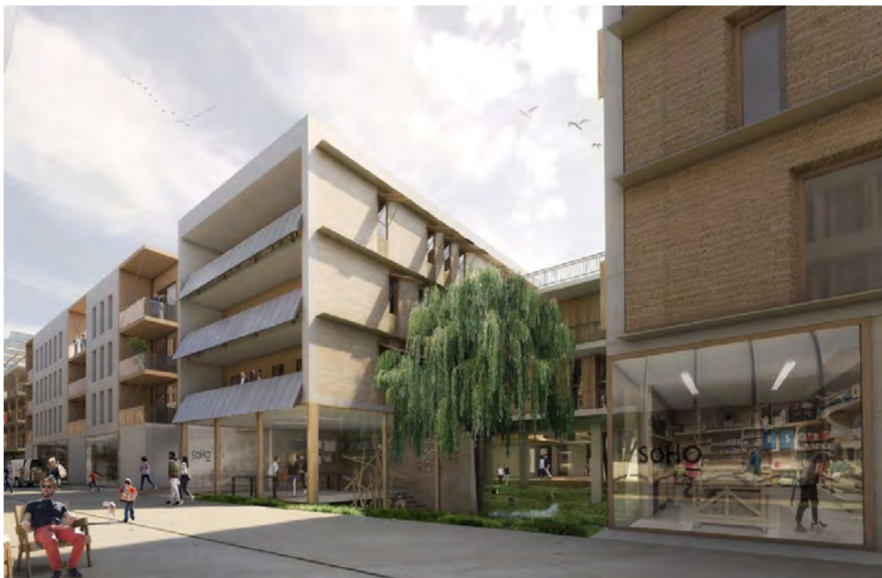
Voie piétonne et façades en maçonnerie de pisé préfabriqué © Amateur Architecture Studio
