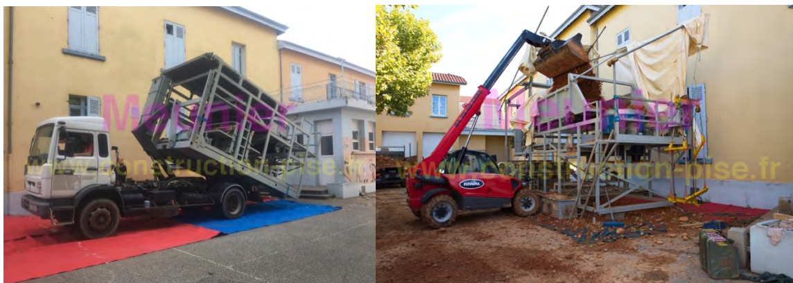
La station de préfabrication est déposée sur le chantier par un camion à bras hydraulique. Sa benne peut être chargée de tout côté, d'un volume de terre de 6m3 environ. Source : construction-pise.fr
