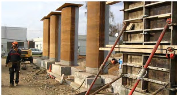
Coffrages métalliques grimpants. Un soin tout particulier est apporté aux formes arrondies des murs bruts, pour offrir aux enfants un environnement tout en douceur. © Design et Architecture
