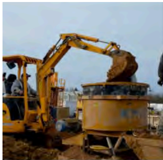
tamiser et mélanger © Q.Chavasang et H.Gasnier
