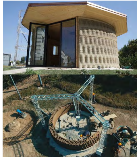
Gaia, la maison imprimée en 3D avec de la terre © 3dwasp
