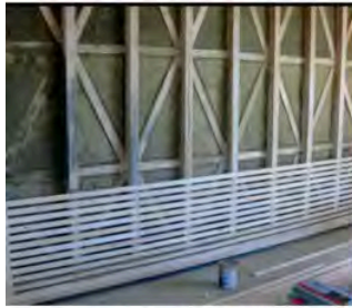
construire la structure
