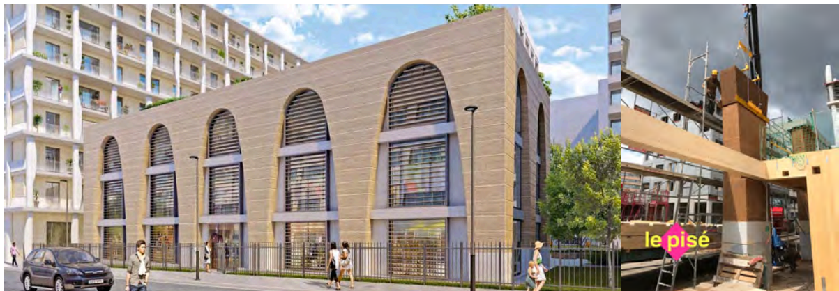
Chacune de ces arches a plus de 4 mètres de portée, pour 9 mètres de hauteur. © Clément Vergély architectes
