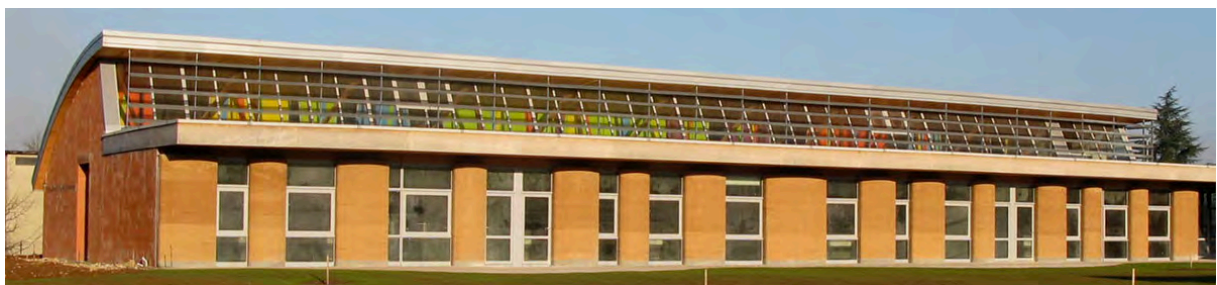
La couverture courbe permet la prise de lumière centrale du bâtiment scolaire et la toiture plate est portée en façade par une sablière sur les murs en pisé © Design et Architecture
