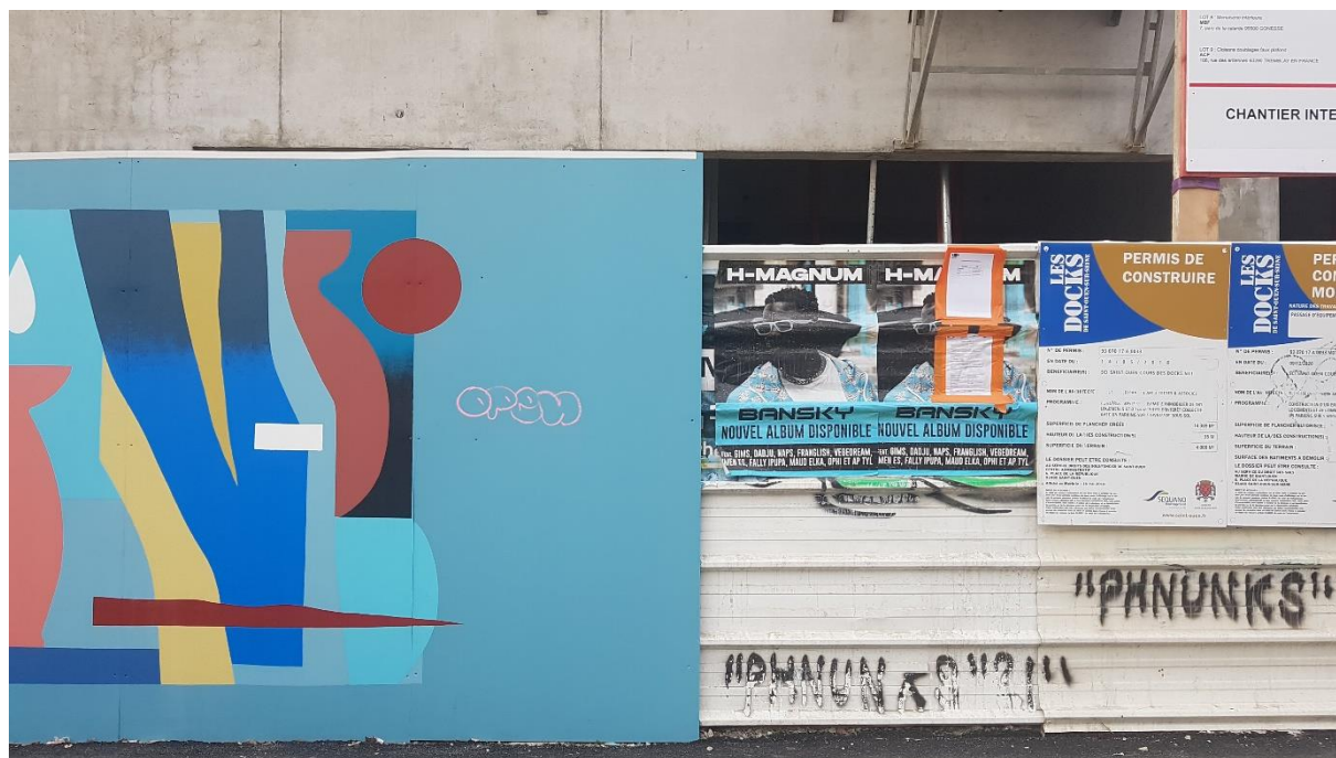
Figure 5 : Différence de traitement entre les palissades artistiques et leurs cousines en tôle
