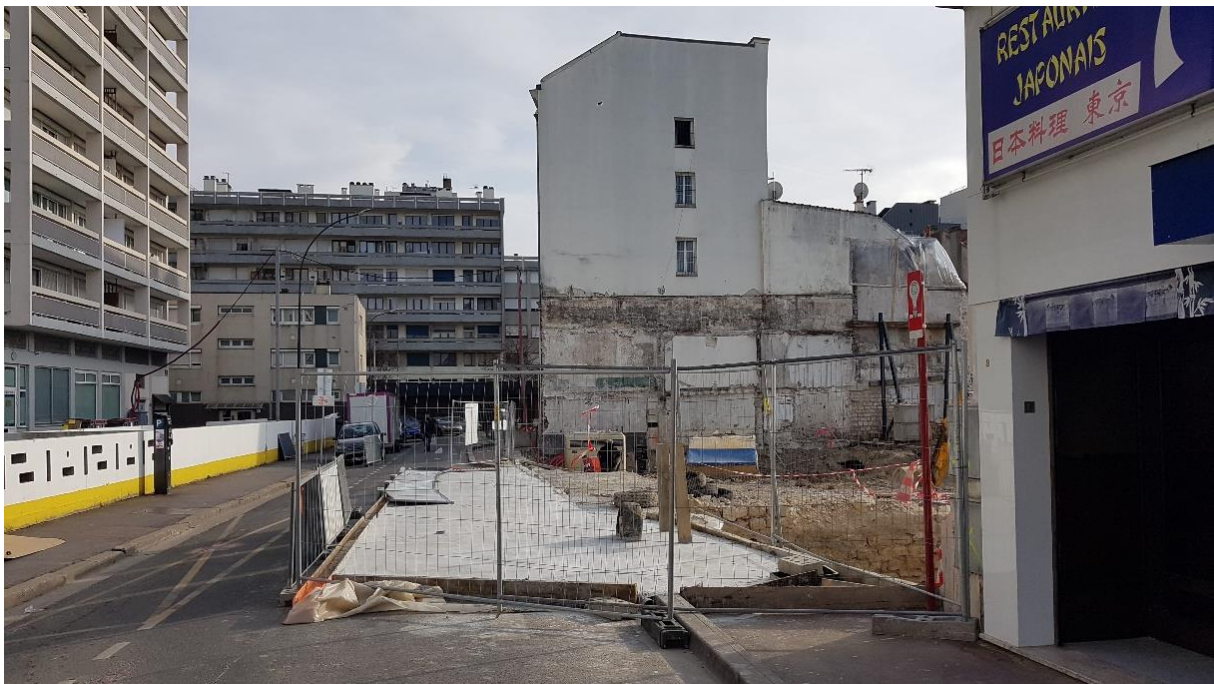
Figure 2 : Photographie d'un chantier rue Antonin Georges Belin à Argenteuil
