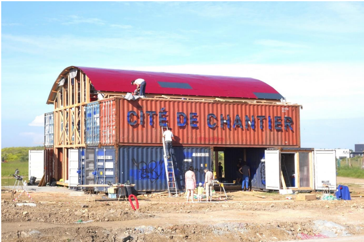
Figure 24 : Photographie de la Cité de chantier de la Grande Halle de Colombelles (Sources : https://www.superterrain.fr )
