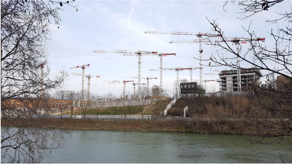
Figure 11 : Le chantier du Village Olympique à Saint-Ouen-sur-Seine et Saint-Denis
