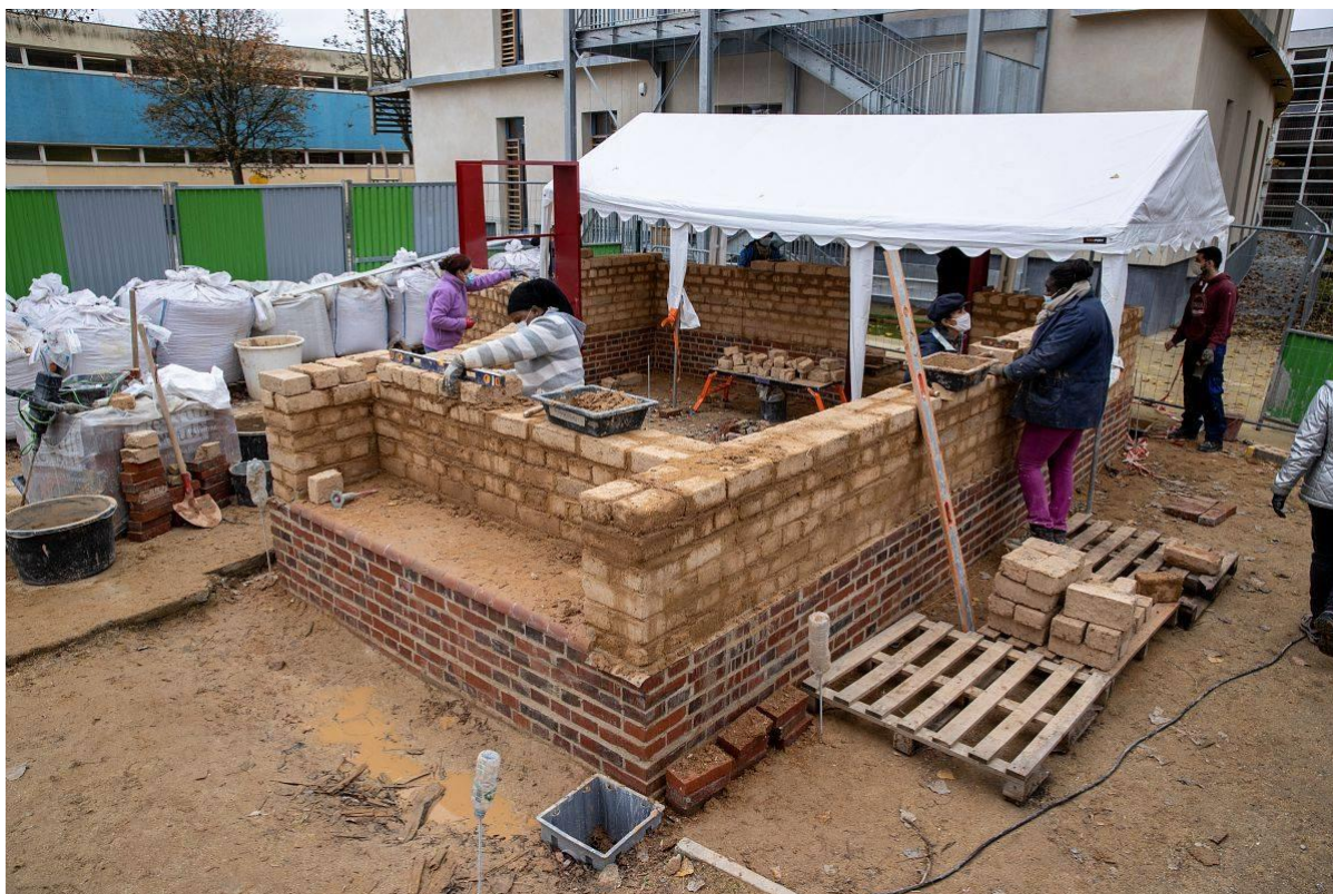
Figure 29 : Chantier école de maçonnerie (Sources : https://www.facebook.com/RosnyOfficiel/photos/pcb.2700753403518897/27007533360185568 )
