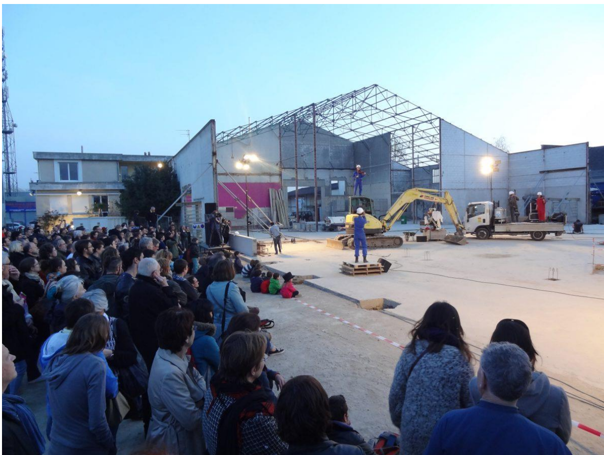
Figure 25 : Photographie de chantier ouvert du Point Haut à Saint-Pierre-des-Corps (Sources : https://compagnie-archi.fr/projets/le-point-haut/ )
