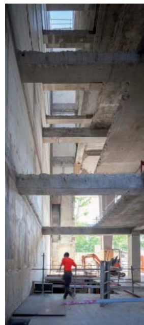
45 Vue de chantier : création de trémies dans les planchers existants. Photo : Hugo Hébrard.
