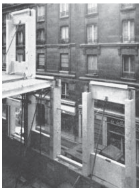
La composition des façades fait penser à un jeu de construction, dont les pièces sont des cadres préfabriqués en Schokbéton que l'on pose en quinconce, les uns au-dessus des autres, et que le coulage du plancher rend solidaires.
