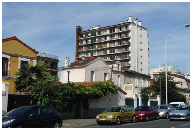
Pavillons et Pavillons et logements collectifs aux Lilas
