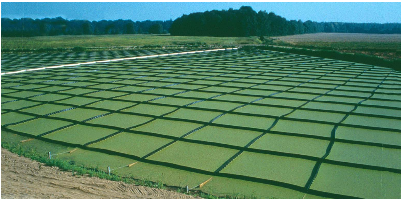
Cette lagune de traitement des eaux usées à Kochice en Pologne a été projetée par l'ingénieur / artiste Viet Ngo. Elle utilise le système Lemna qu'il a mis au point et qui se base sur l'utilisation de lentilles d'eau.
