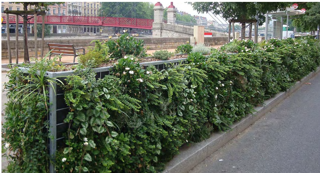
Mur antibruit végétalisé, quai Fulchiron, Lyon, Ecolyon 2011. La végétation n'est en fait utilisée ici que pour masquer le mur antibruit.
