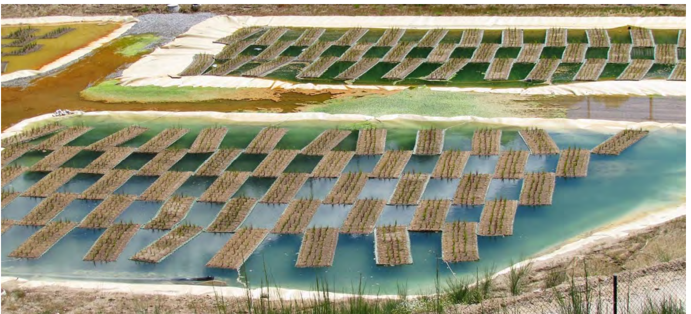
Réhabilitation d'une ancienne mine d'uranium, Cunha Baixa, Viseu, Portugal. Les plantes sont ici incorporées dans un substrat flottant, les racines descendent dans l'eau et participent au processus de récupération et de dégradation des métaux lourds.
