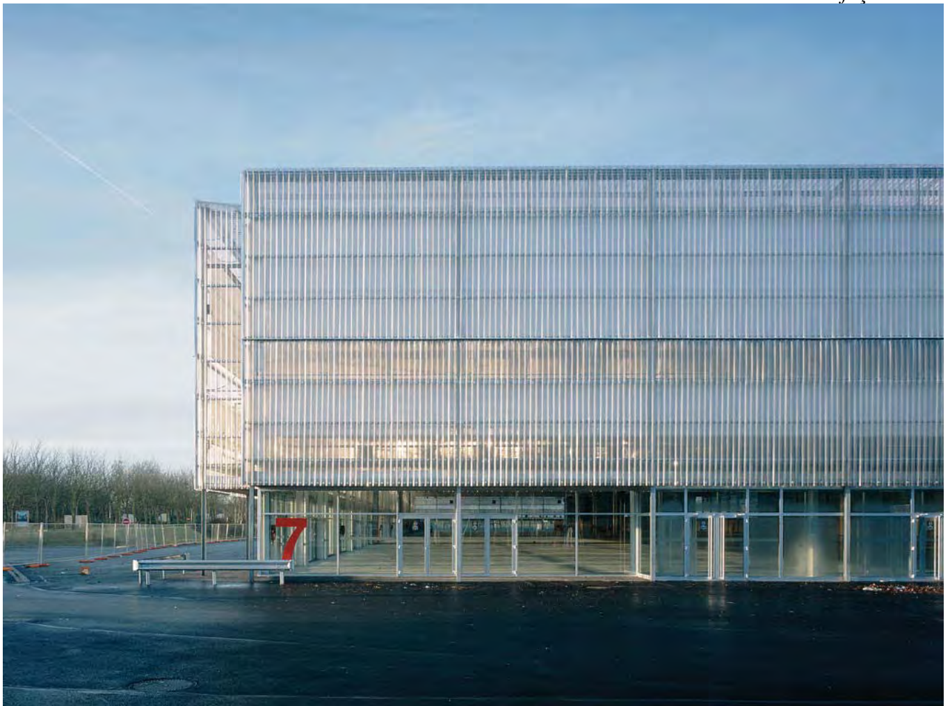
Vue sur la façade Sud
