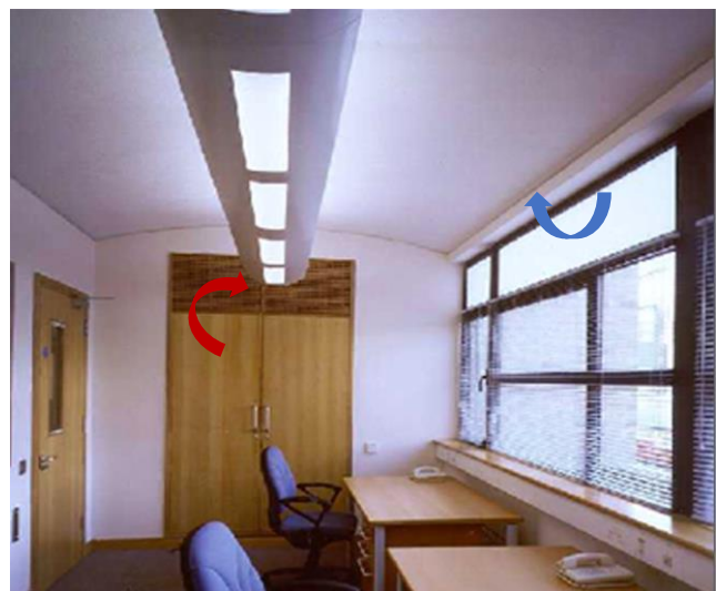
Fig. Bureaux côté rue : grille air neuf et reprise 57 Fig. Bureaux côté cour : grille de reprise et air neuf dans les châssis 58
