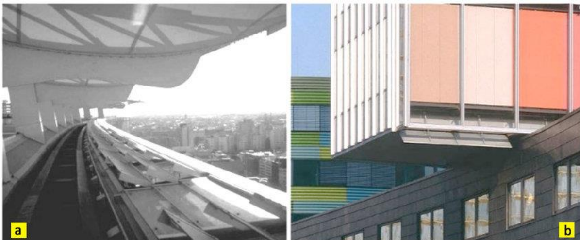
Grille pare-pluie pour l'extraction en partie haute et ouvrant lié à la GTB en partie basse de la façade Ouest 99
