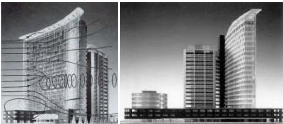
Impact flux d'air sur la façade Ouest du bâtiment 86
