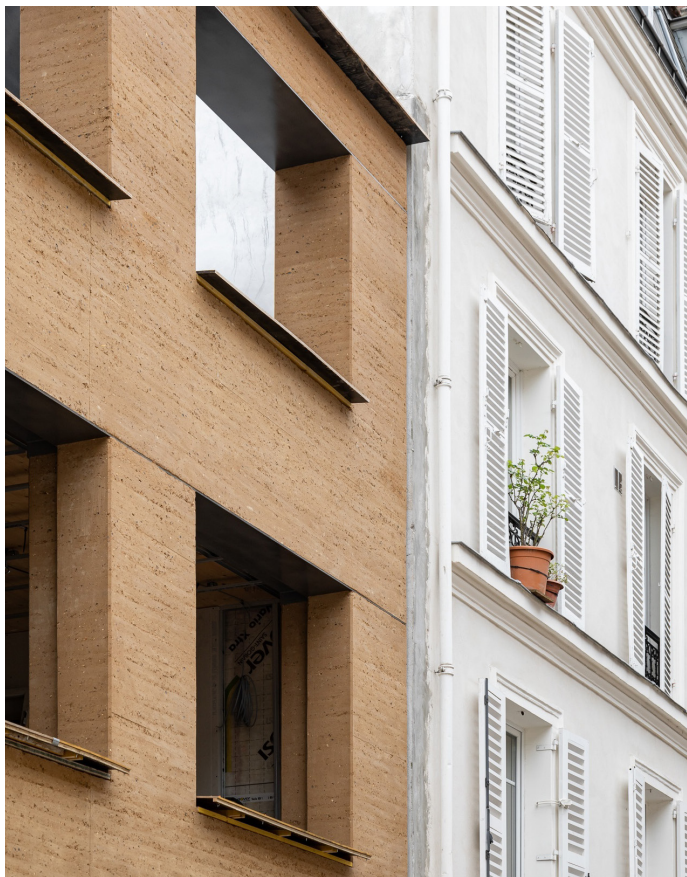
Dechelette Architecture, façade en terre crue, Cité Nollez, Paris 18, en chantier, photographie : Dechelette Architecture
