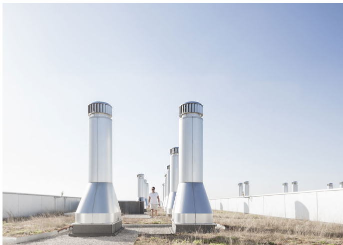
Atelier Pascal Gontier, Bâtiment Max Weber , université Paris Nanterre, 2016 Ventilation naturelle, matérialisation et visibilité de la technique «passive»
