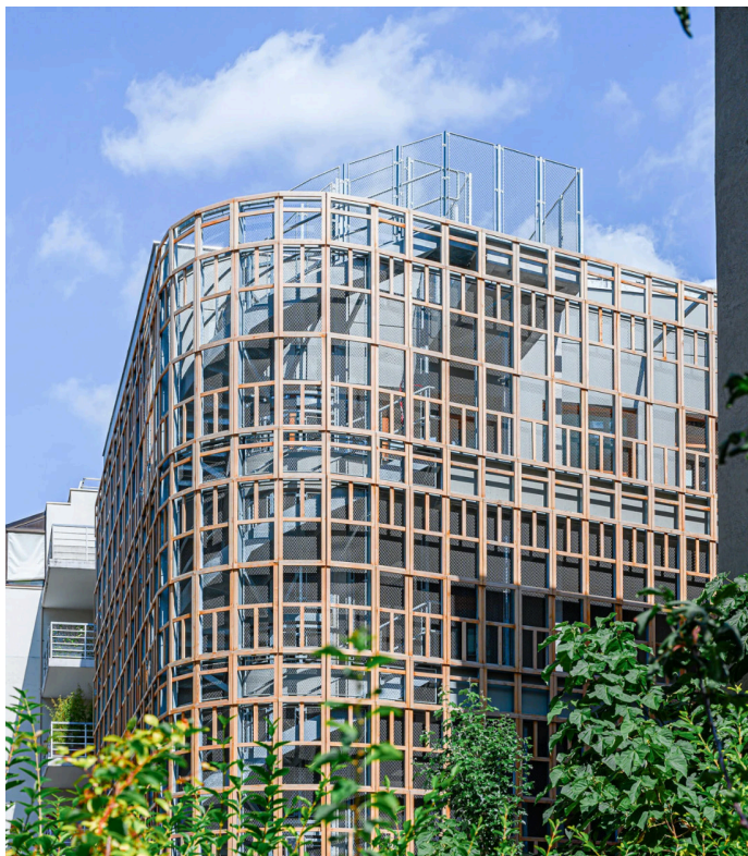
BFV architectes, Justice pour tous, photo de la façade principale en bâti de portes réutilisés, accompagnement par Bellastock photographie : BFV
