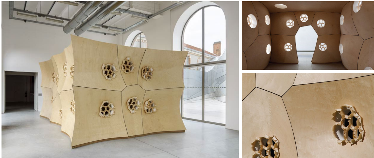
Fig. 3-11. L'HYGROSKIN® est une paroi « méteosensitive » composée de bois mêlé à un matériaux composite capable de réagir aux variations de l'humidité de l'air.
