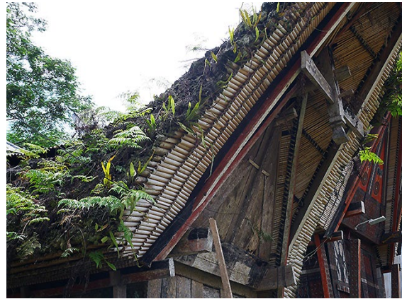
Fig. 1-2. Détail d'une toiture de maison Toraja avec toit en chaume et bambou, structure en bois.
