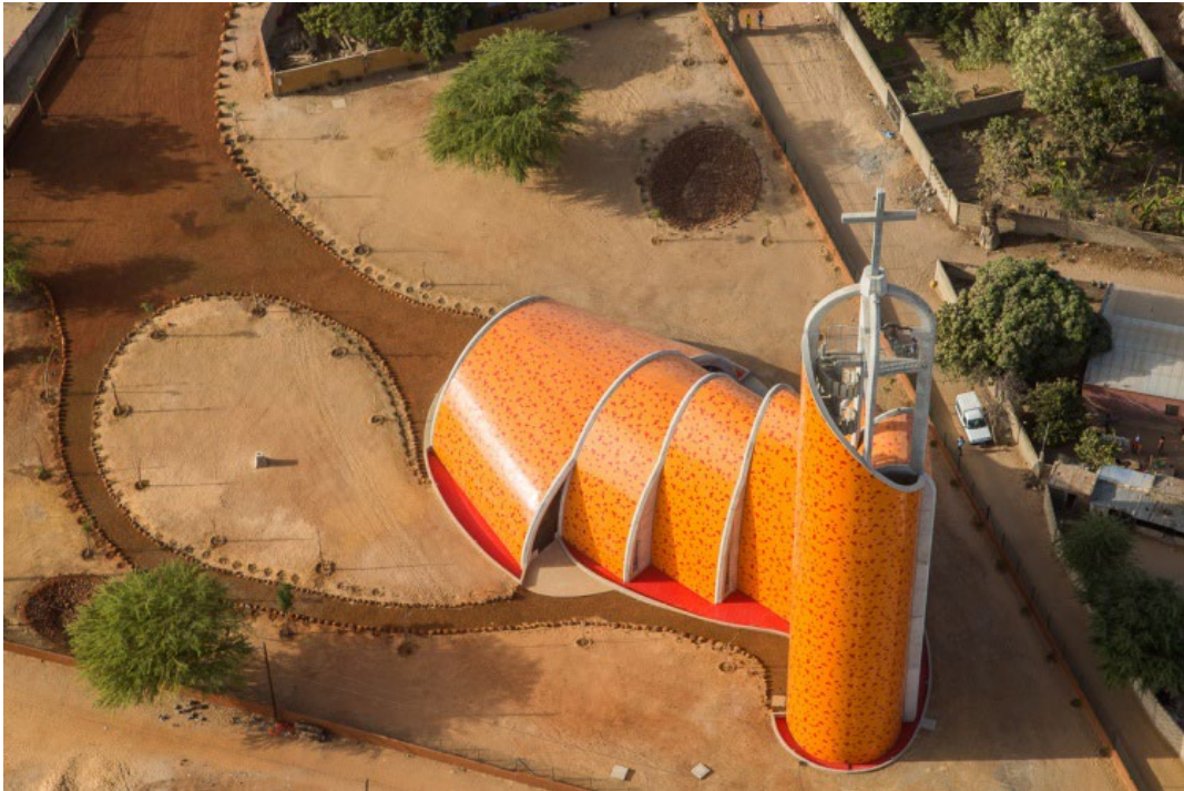
Fig. 3-1. L'église de Nianing au Sénégal est un bel exemple de la liaison entre conception bioclimatique et abstraction du fonctionnement de la termitière africaine, grâce à la biomimétique. Projet par IN SITU Architecture - 2019
